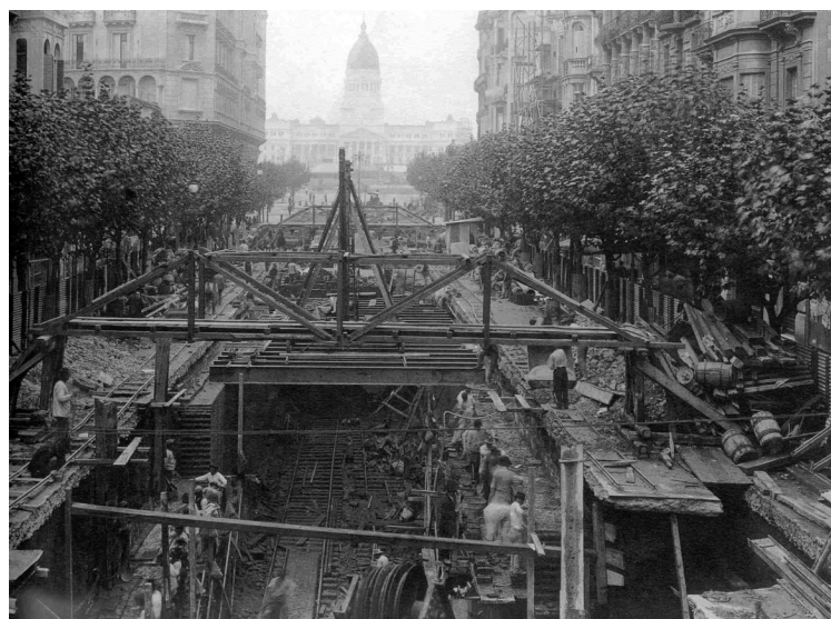
Figura 7. “La ciudad destripada”. Excavación Línea A, método “a cielo abierto”. Fuente: Gutman, 1999.
